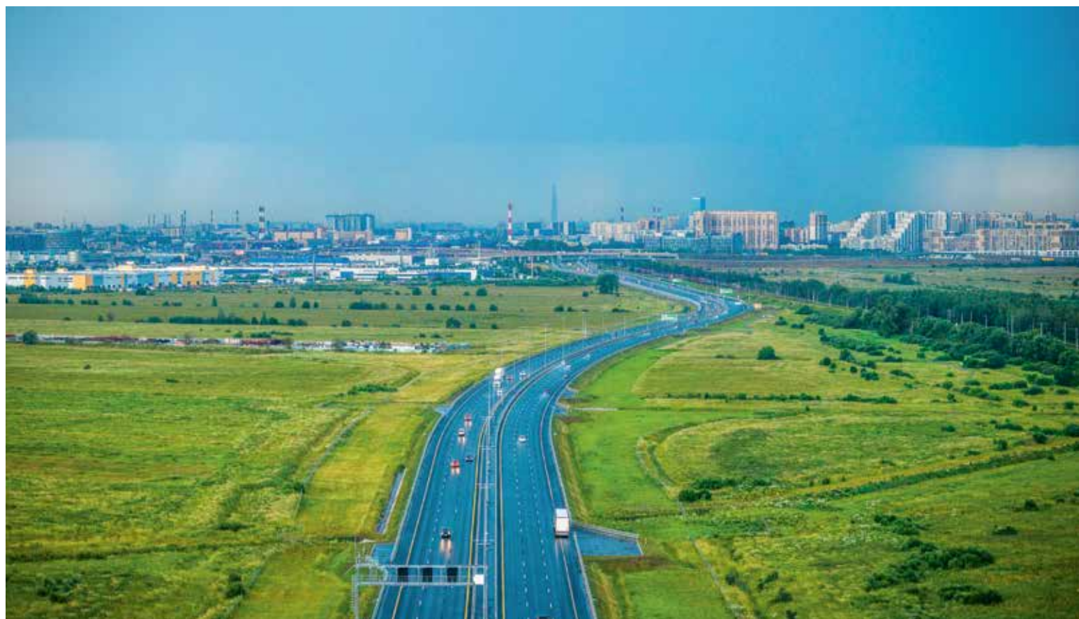
Строительство транспортных развязок на М-11 «Нева» обеспечивает подъезд к скоростной трассе и открывает новые возможности для развития экономики прилегающих территорий.
