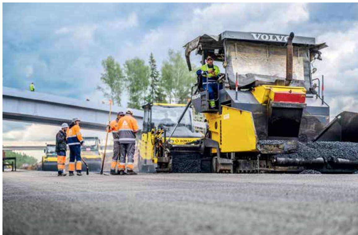
В рамках развития Центральной кольцевой автодороги продолжается строительство транспортной развязки на пересечении третьего пускового комплекса ЦКАД и Дмитровского шоссе.
