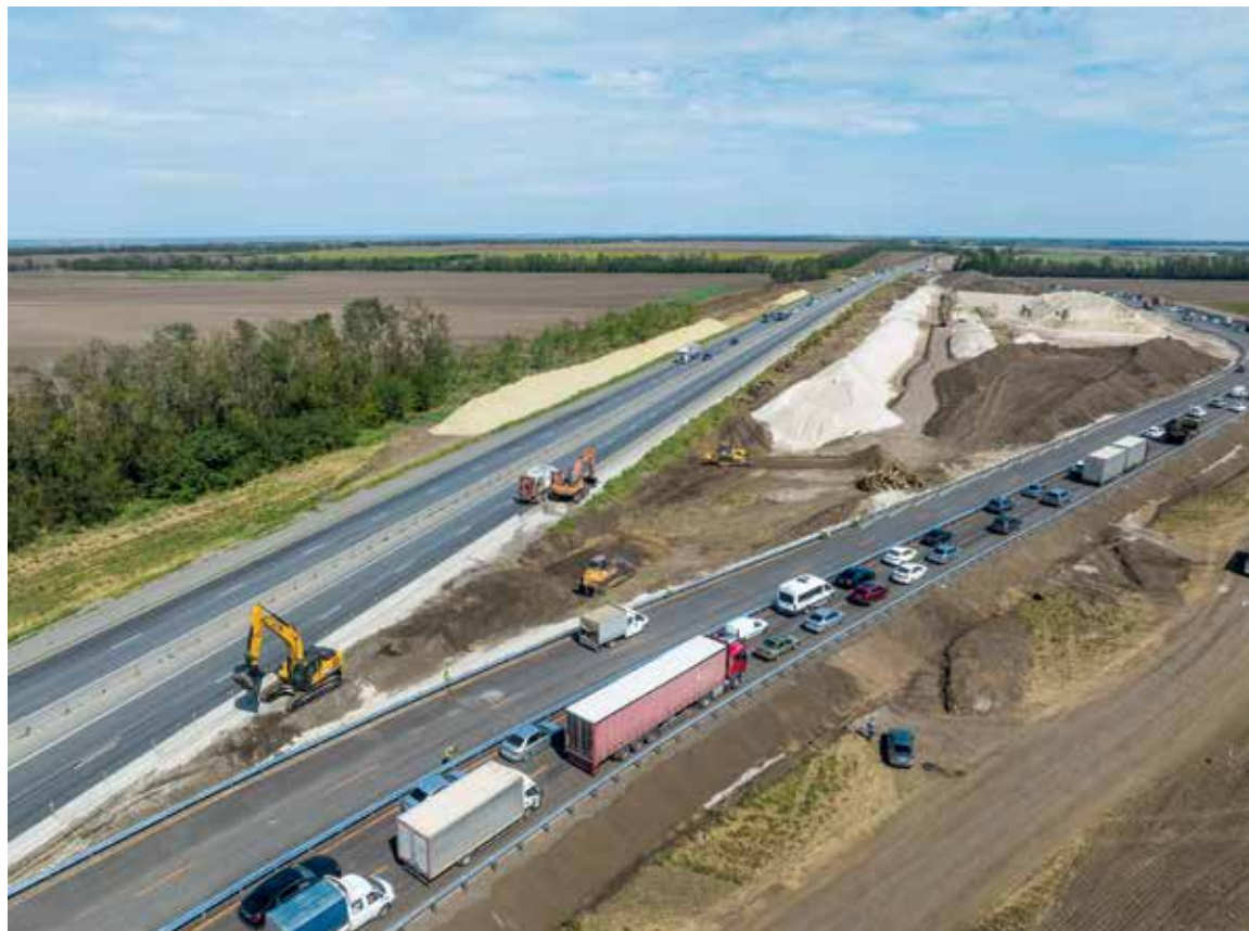
В результате реконструкции трассы М-4 «Дон» с 933-го по 1024-й км в Ростовской области дорога будет расширена до шести полос, что позволит обеспечить комфортное и безопасное скоростное движение.
