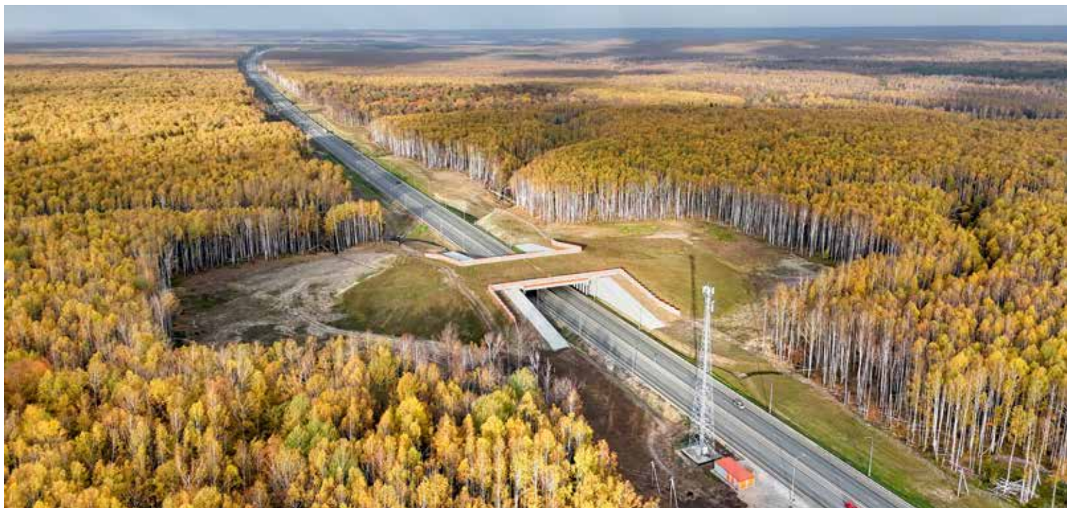
Экодук – искусственное сооружение над скоростной трассой, которое позволяет диким животным безопасно пересечь магистраль.
